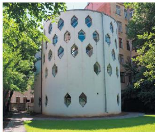
«Круглый дом». Архитектор К. С. Мельников
