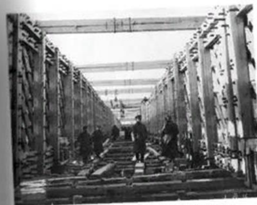
Возведение деревянного железнодорожного моста на реке Нарва
