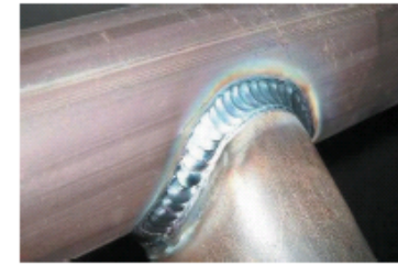
Рис. 2.10. Соединение труб электродуговой сваркой
