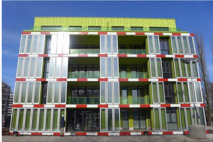
BIQ house – первое в мире здание с энергией от водорослей
