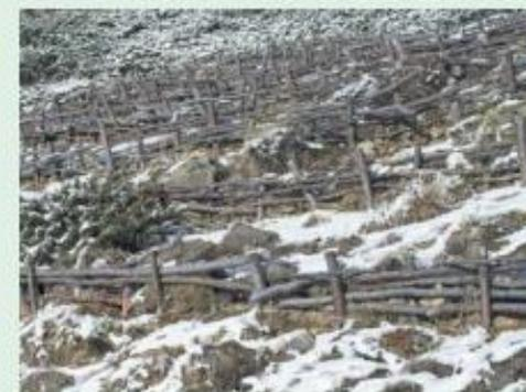
*Для удержания крутых склонов используют подпорные стенки из дерева, камня, кирпича или бетона*
