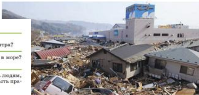
Рис. 118. Последствия сильного землетрясения
