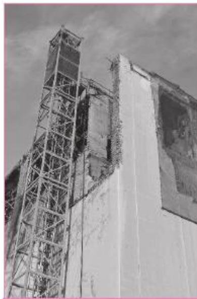
Блок, разрушенный после взрыва на АЭС «Фукусима-1»
